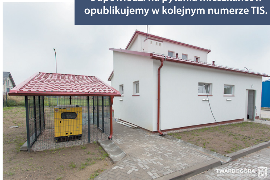
SUW w Grabownie Wielkim na ukończeniu
