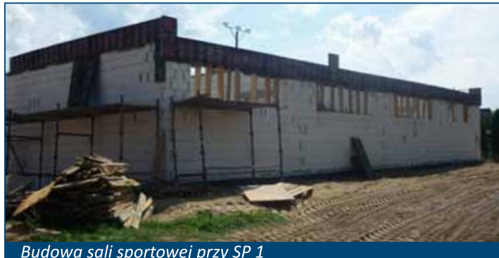
Budowa sali sportowej przy SP 1
