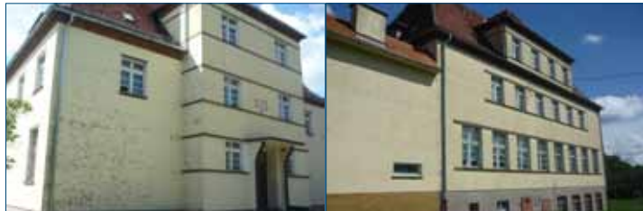
Budynek byłej szkoły w Chełstowie
