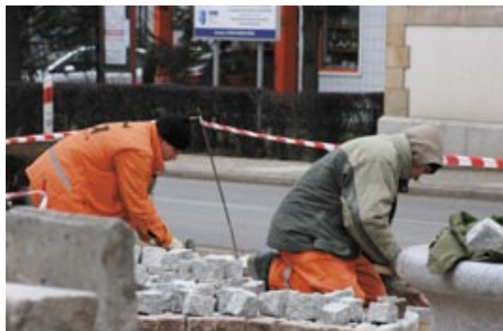
Pod koniec lutego trwały prace przy pierzei południowo-zachodniej
